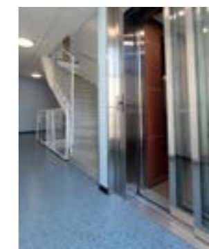
la cage d'escalier. Ascenseur installé à
