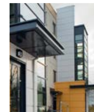
l'intérieur de la cage d'escalier et les escaliers placés à l'extérieur.
